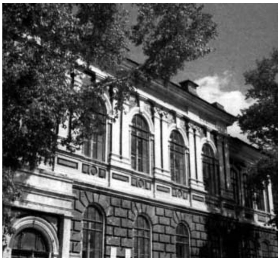
В этом здании было духовное училище. В настоящее время — один из корпусов педагогического института
